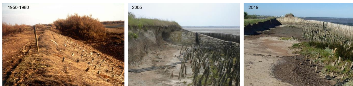
Figure 32 : Evolution de l'érosion de la digue à Malprat entre la fin du XX ème siècle et 2019 (Photos : Conservatoire du littoral)
