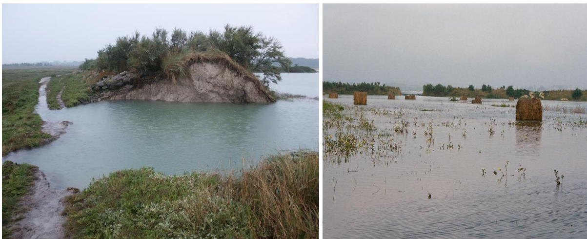
Illustration 10 – Brèche formée dans la digue de Ploubalay en 2006 (à gauche) et submersion associée (à droite) (clichés du Conservatoire du littoral et de la CCCE).
