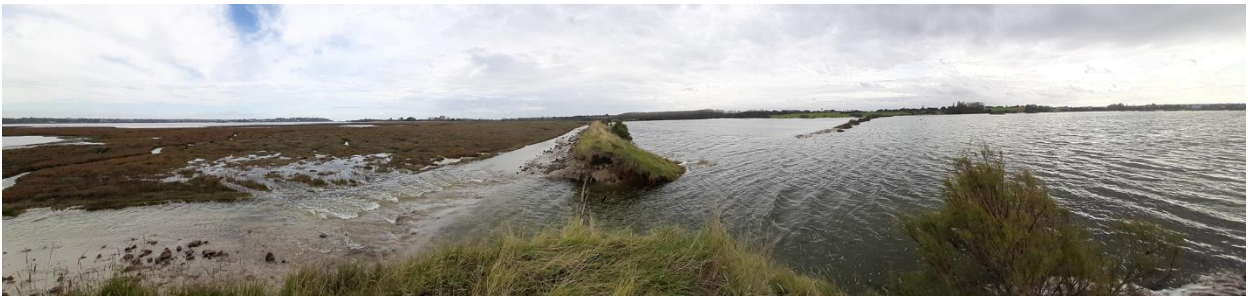
Illustration 16 - Vue de la brèche depuis la digue côté Sud le 20 Octobre 2020 (3 heures après la pleine mer, coefficient 112) avec l'eau sortant du polder à marée descendante (Conservatoire du littoral).
